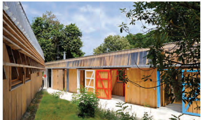
Résidence Suzanne Lacore. Maîtrise d'oeuvre : Patrick Hernandez, Jean-Hugues Seurat, architectes DPLG / Bureau d'études structure : Cube Ingénieurs bureau / Bureau d'études thermiques et fluides : Beyle
