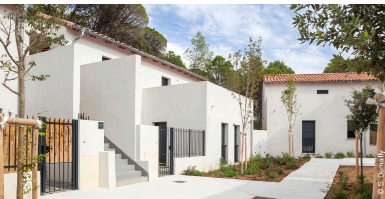
Double inauguration pour 3F Sud à Jouques (13) en novembre, celle de la résidence l'Oliveraie et de son 10 000 e logement. Dans les 16 bâtiments, le chauffage et la production d'eau chaude individuelle sont assurés grâce à une pompe à chaleur thermodynamique double service couplée d'un ballon de stockage pour l'eau chaude sanitaire.
