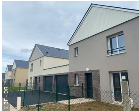
À Berneval-le-Grand (76), livraison en octobre de 19 maisons et 4 terrains à bâtir - 3F Normandie.
