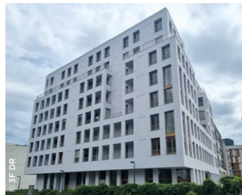
À Orléans (45), 50 logements collectifs en entrée de ville - 3F Centre Val de Loire.
