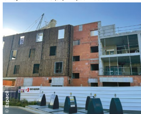
Construction de la résidence Lélia à Noyal-sur-Vilaine (35) – Espacil Habitat.
