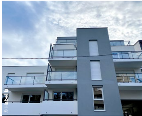
17 logements locatifs sociaux rue des Saunières, à Dijon (21) – Habellis.
