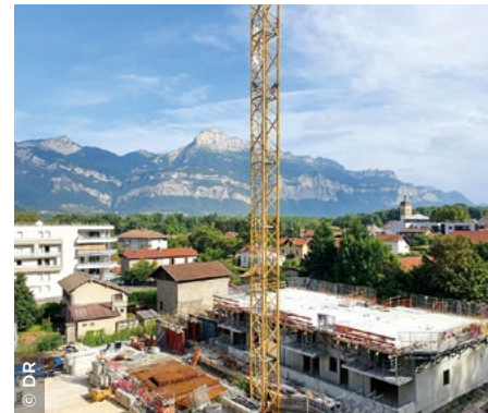
À Villard-Bonnot (38), construction de la résidence Le Kalysto - la SDH.
