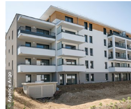
À Thonon-les-Bains (74), la résidence Intermezzo en fin de chantier - Alliade Habitat.
