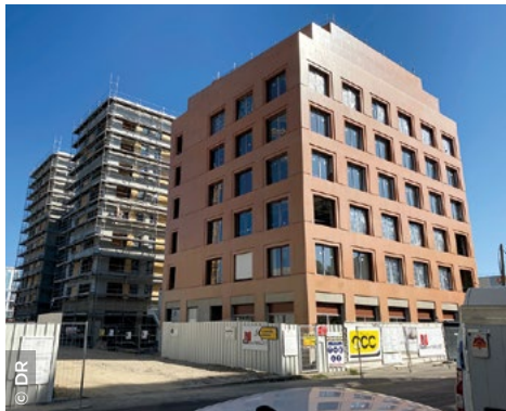
À Lyon, construction par Grand Lyon Habitat de 86 logements cofinancés par Action Logement Services.
