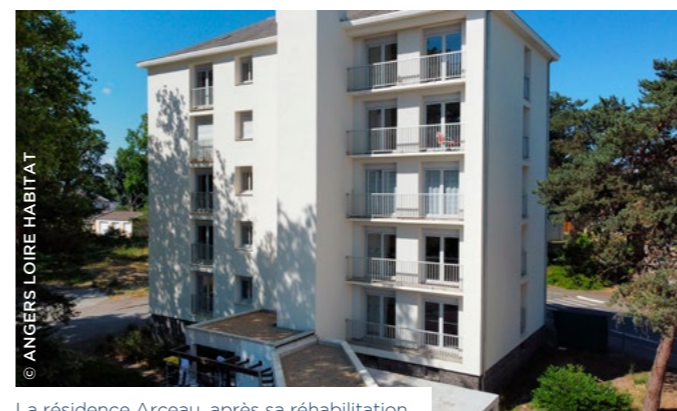
La résidence Arceau, après sa réhabilitation.
