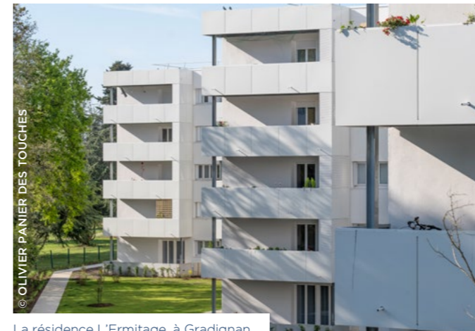
La résidence L'Ermitage, à Gradignan.
