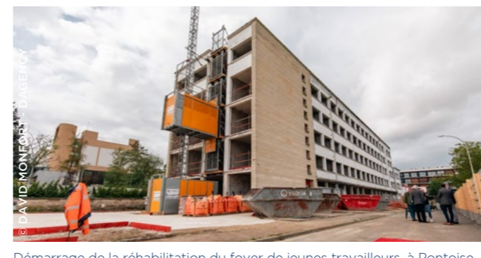
Démarrage de la réhabilitation du foyer de jeunes travailleurs, à Pontoise.
