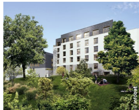
La future résidence universitaire Loire Campus, dans le quartier Tortière à Nantes (La Nantaise d'Habitations).
