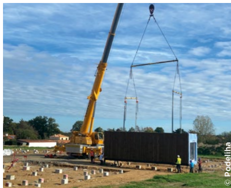
Le 26 octobre à Chanverrie, pose d'un module Habiflex®, concept inédit d'habitat flexible et transitoire (Podeliha).
