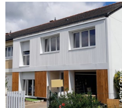
À Angers, 32 maisons de la rue d'Auvergne ont été réhabilitées selon la démarche EnergieSprong (Podeliha).
