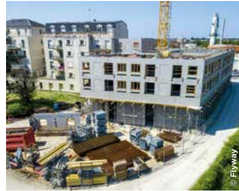
Le 9 mai 2022, la construction de 50 logements dans la ZAC Coligny à Orléans (3F Centre Val de Loire).
